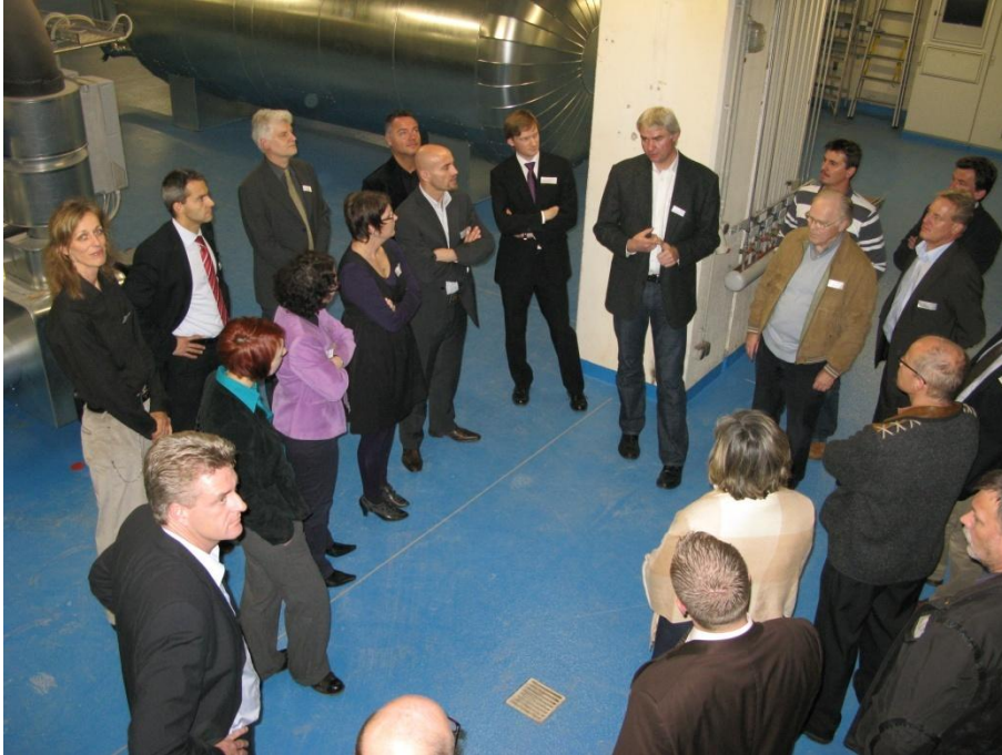
Picco Bello: Die Sauberkeit in den Technikräumen des Gasteig
